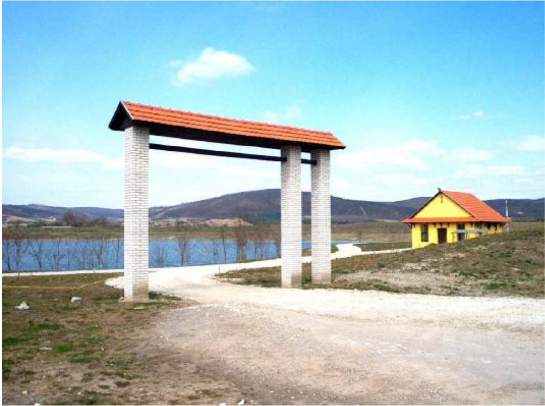
7/j. melléklet A bejárati kapu és a porta épület
