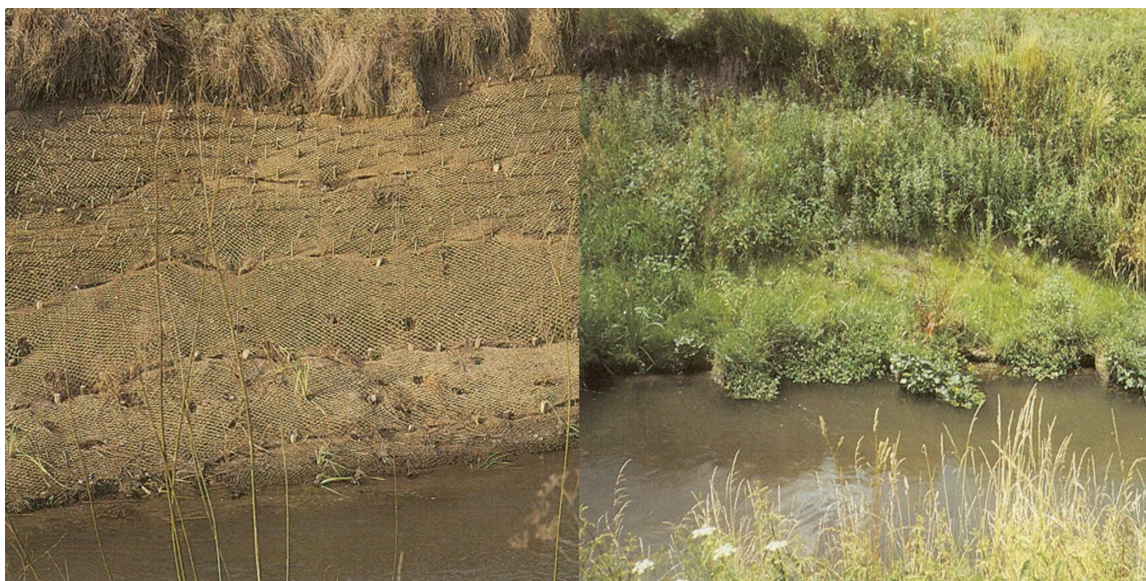
8. kép: Az Isen-folyó rézsűbiztosítása műanyag szövettel és élő növényzettel (Forrás: Stoiber – Gauweiler, 1989.)
